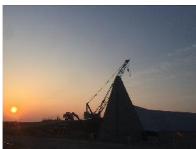
防潮堤視察（只出漁港）
