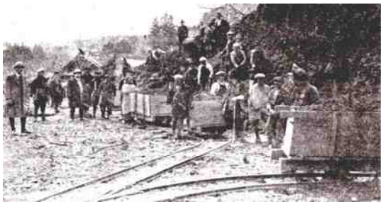
細浦湾埋立工事 大正13年
